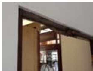
voor de renovatie
